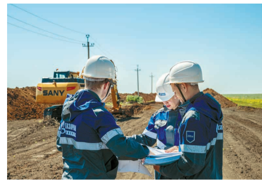
Специалисты группы строительного контроля ИТЦ сверяют соответствие выполненных работ проектной документации
