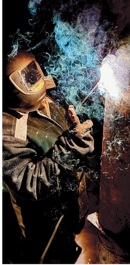
«Сварочные работы», фото Алексея Торопова
