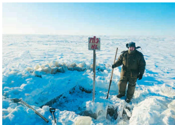
Определение точного местоположения оголовка №1 насосной станции первого подъема п. Ямбург с помощью GPS-позиционирования и подготовительные работы к вырубке майны
