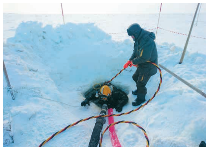
Спуск водолаза на дно акватории Обской губы для проведения работ по очистке водозаборного сооружения первого подъема п. Ямбург
