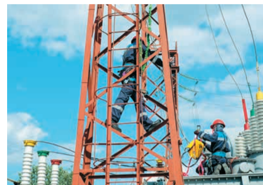
Во время съемок учебного фильма «Средства индивидуальной защиты для выполнения электромонтажных работ на высоте»
