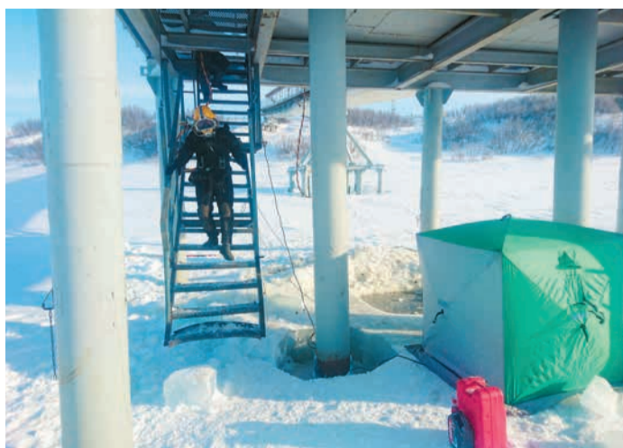
Подготовка к спуску водолаза к оголовкам станции первого подъема водозабора на р. Хадуттэ Харвутинской площадки ЯГКМ
