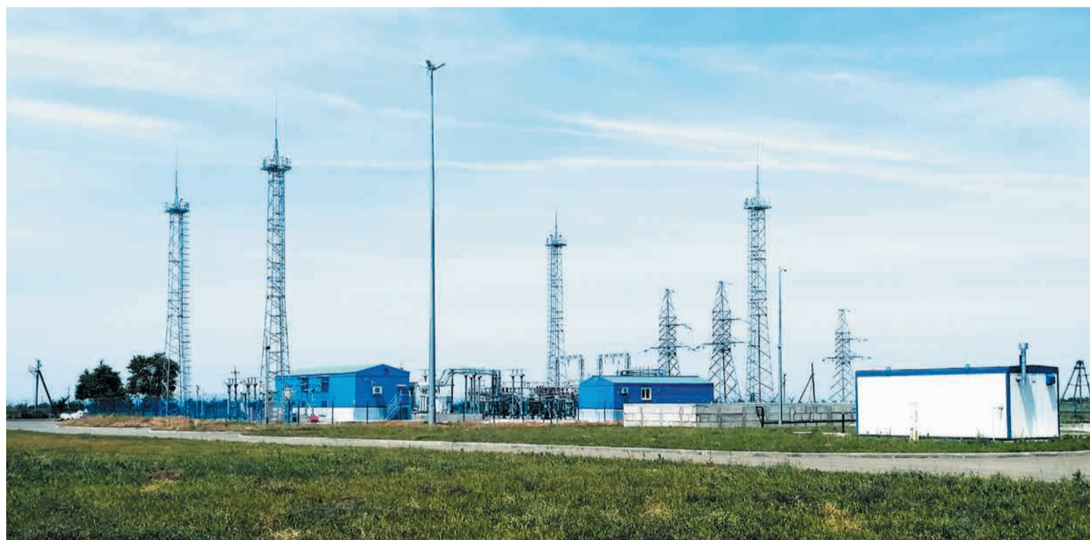
Электрическая подстанция ПС 35/10/6 кВ «Компрессорная», Республика Адыгея
