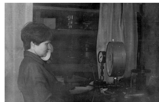
Людмила Крайко, слесарь по КИПиА, проводит работы по ремонту и калибровке средств измерения давления
