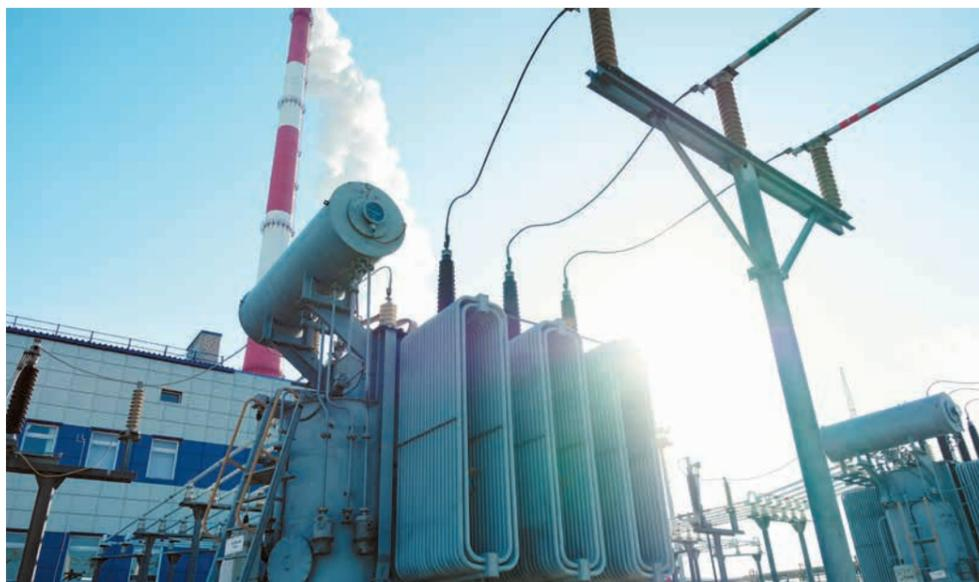
Циркулярные трубы охлаждения масла трансформатора на фоне трубы Пусковой котельной
