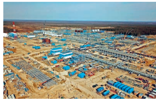
Установка комплексной подготовки газа
