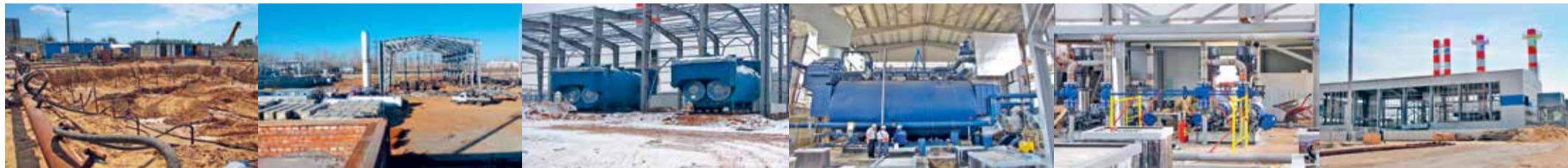
Этапы строительства Котельной. Расширение
