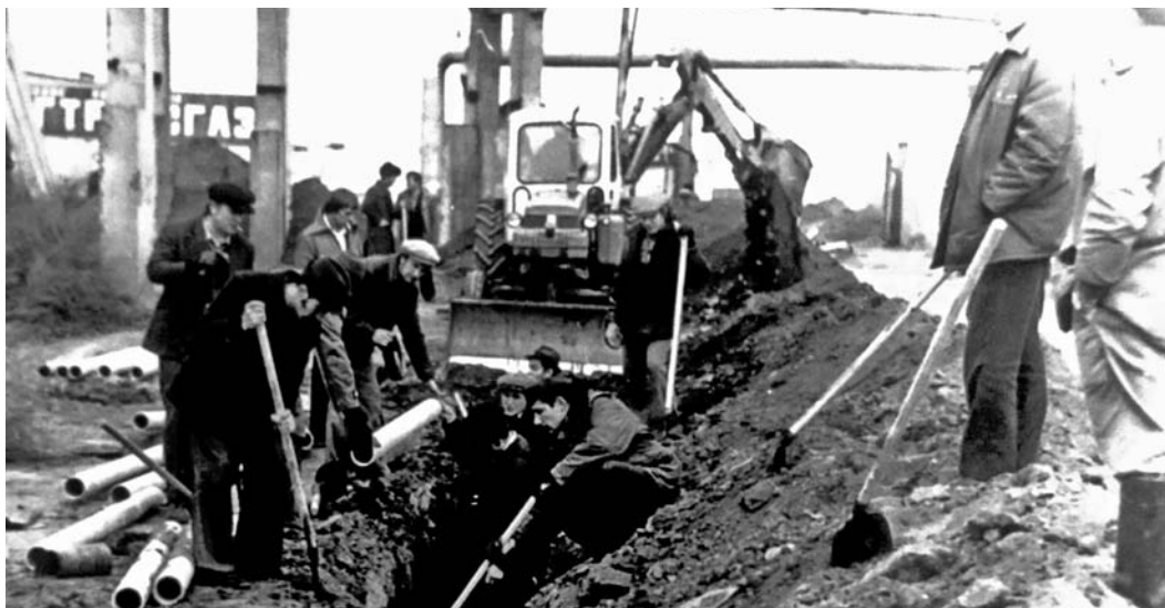
Коллектив РБУ на субботнике, посвященном дню рождения Ленина. Прокладка кабеля
