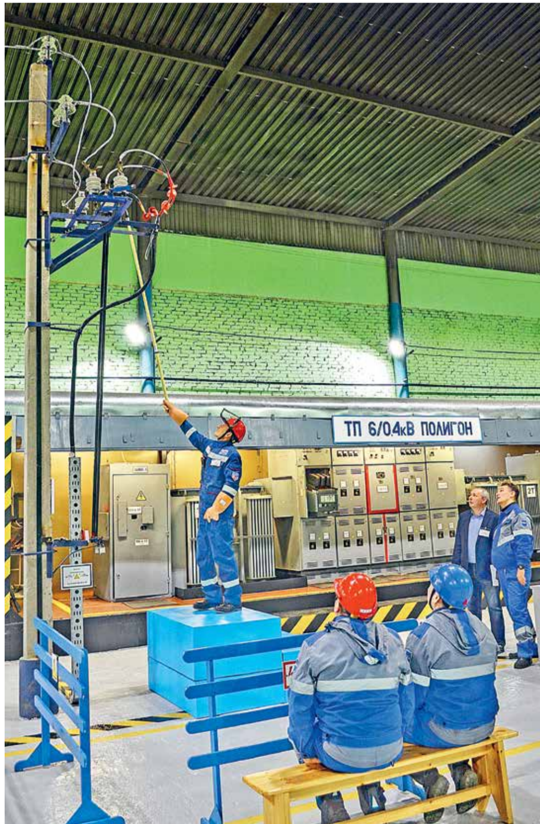
Проверка наличия напряжения на линии электропередачи
