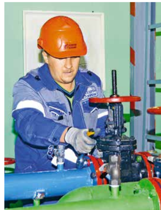
Евгений Головин выполняет задание по изготовлению и замене прокладок запорной арматуры
