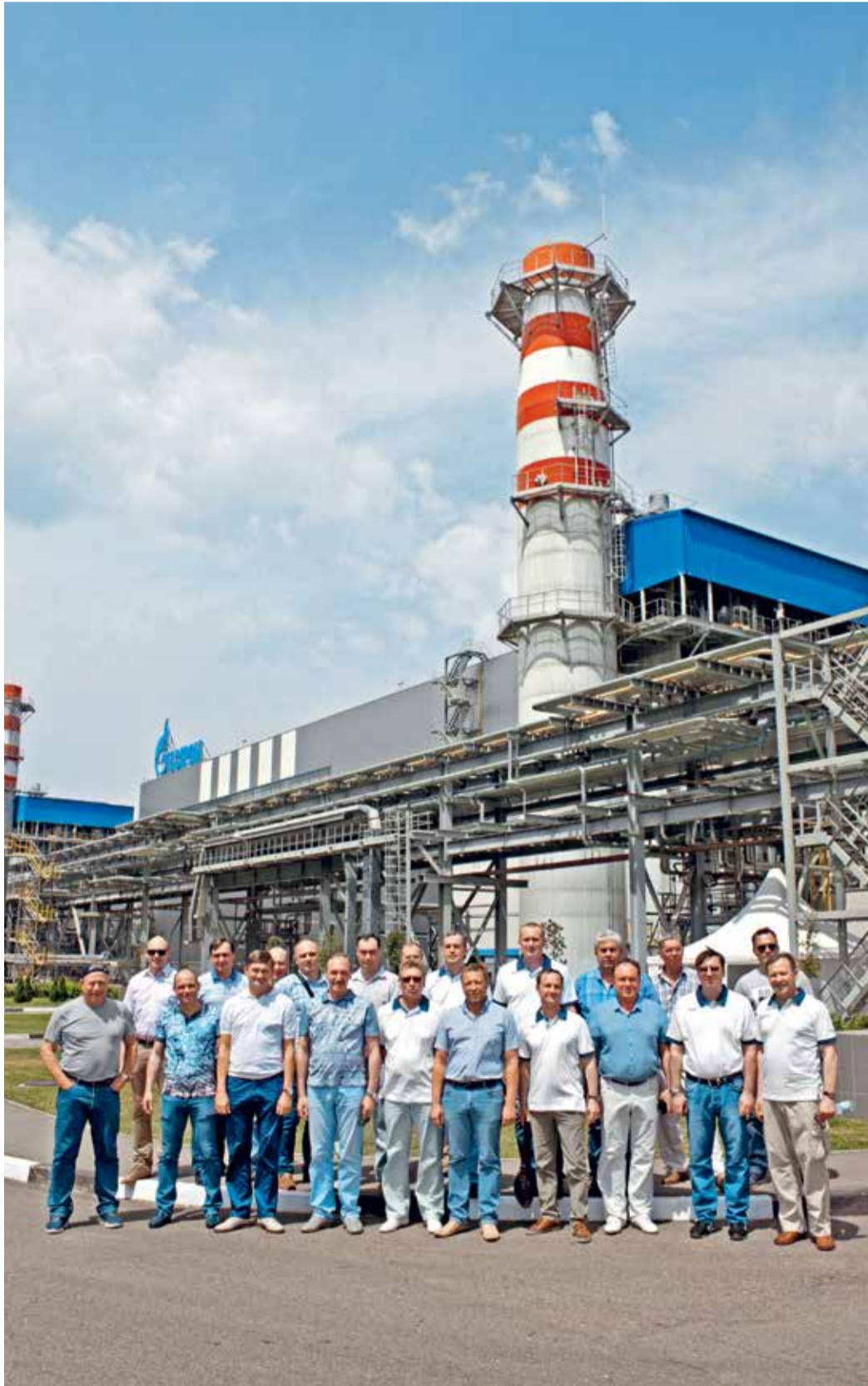
Участники совещания посетили производственные объекты филиала ПАО «ОГК-2» — Адлерская ТЭС — современную парогазовую электростанцию мощностью 360 МВт
