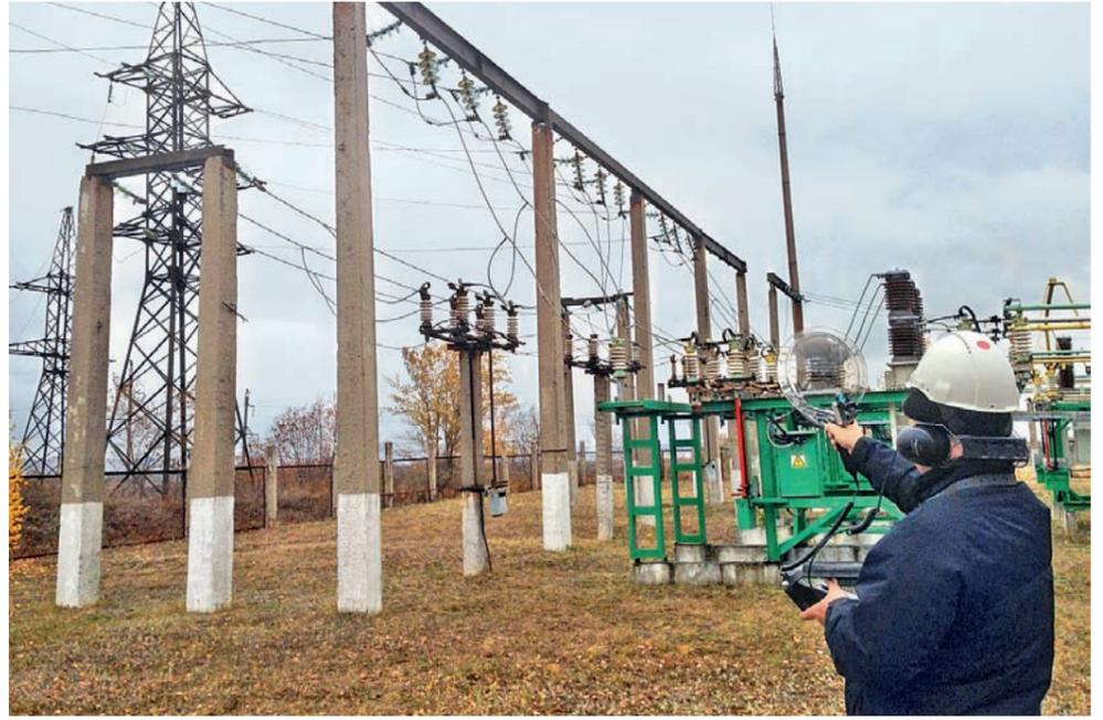
Обследование ПС 35/10 кВ КС-8 с помощью системы Sonaphone M
