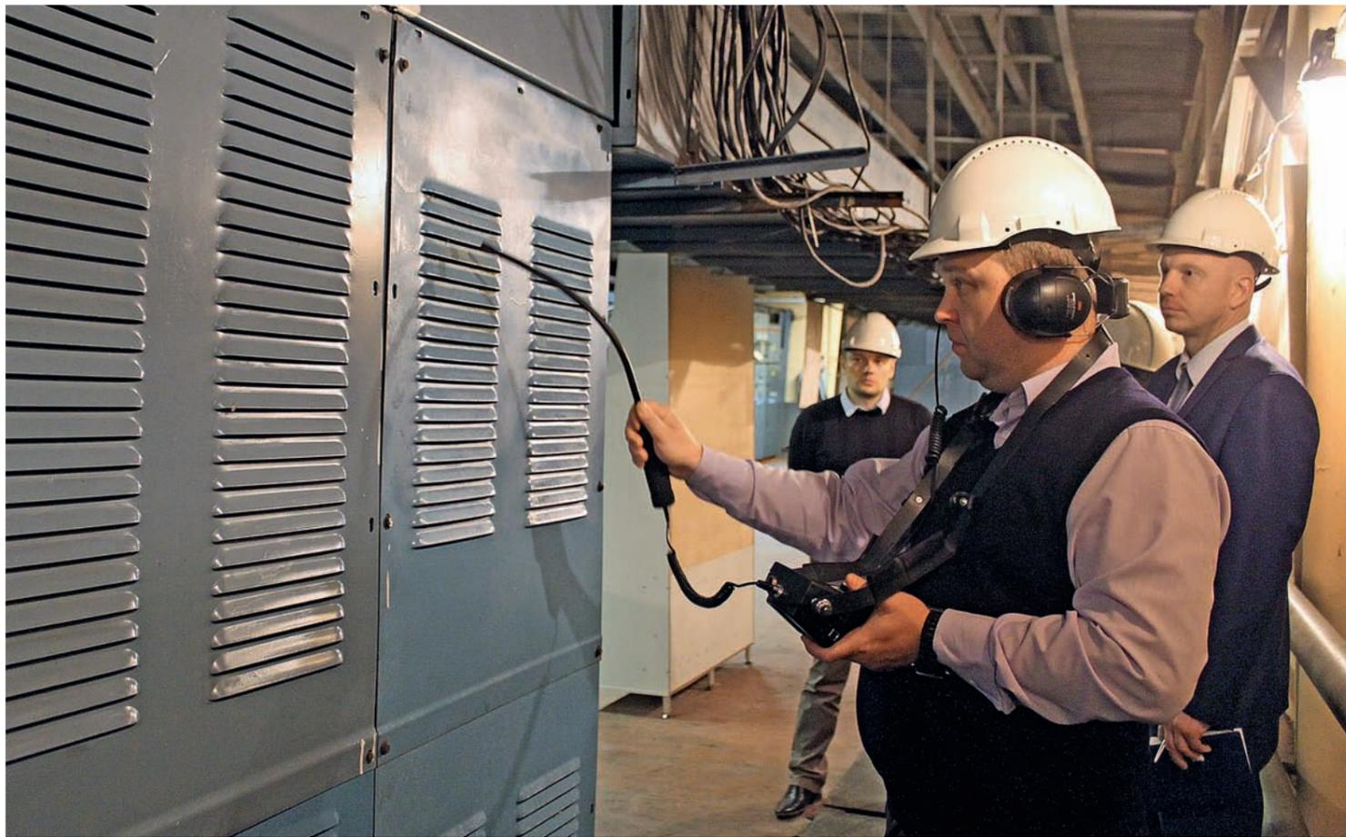
Диагностика ячейки ЗРУ 10 кВ КС-21 акустическим датчиком
