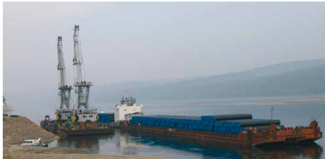
Поставка труб для строительства газотранспортной системы «Сила Сибири»
