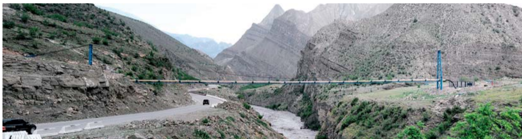
Вантовый переход газопровода-отвода к селению Хунзах Хунзахского района Республики Дагестан через реку Андийское Койсу
