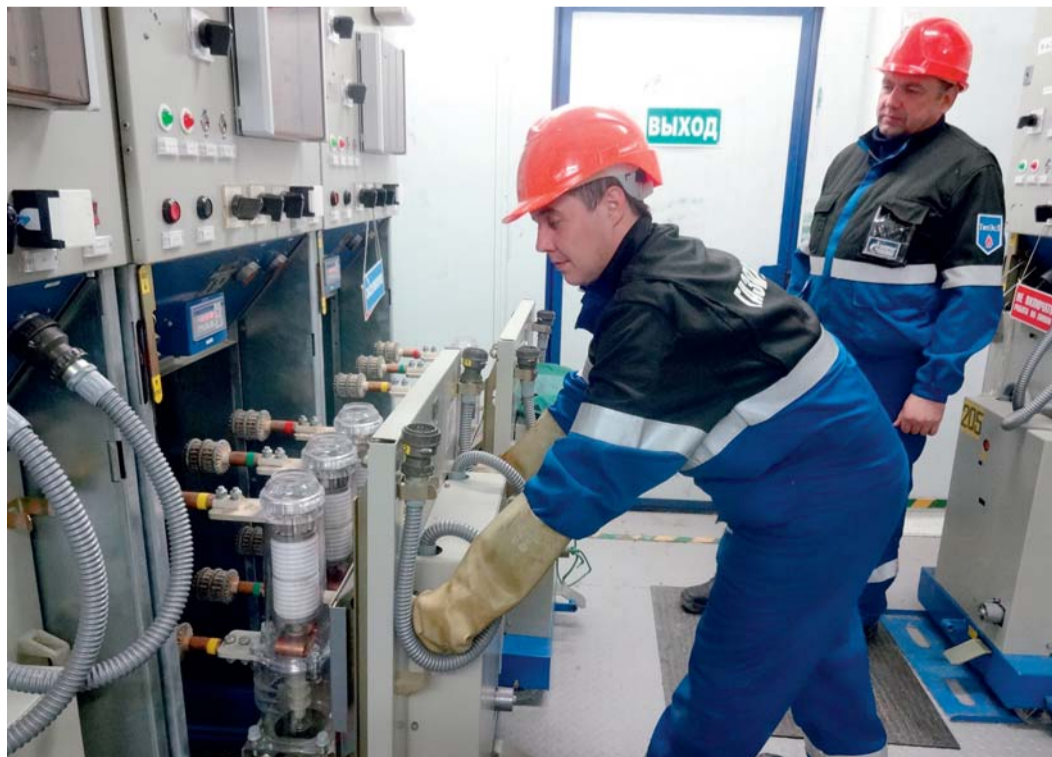
Сергей Поляков и Владимир Чернышёв, электромонтёры по эксплуатации распределительных сетей, производят вывод в ремонтное положение отходящей ячейки ЗРУ6кВ ПС 110кВ УКПП-9
