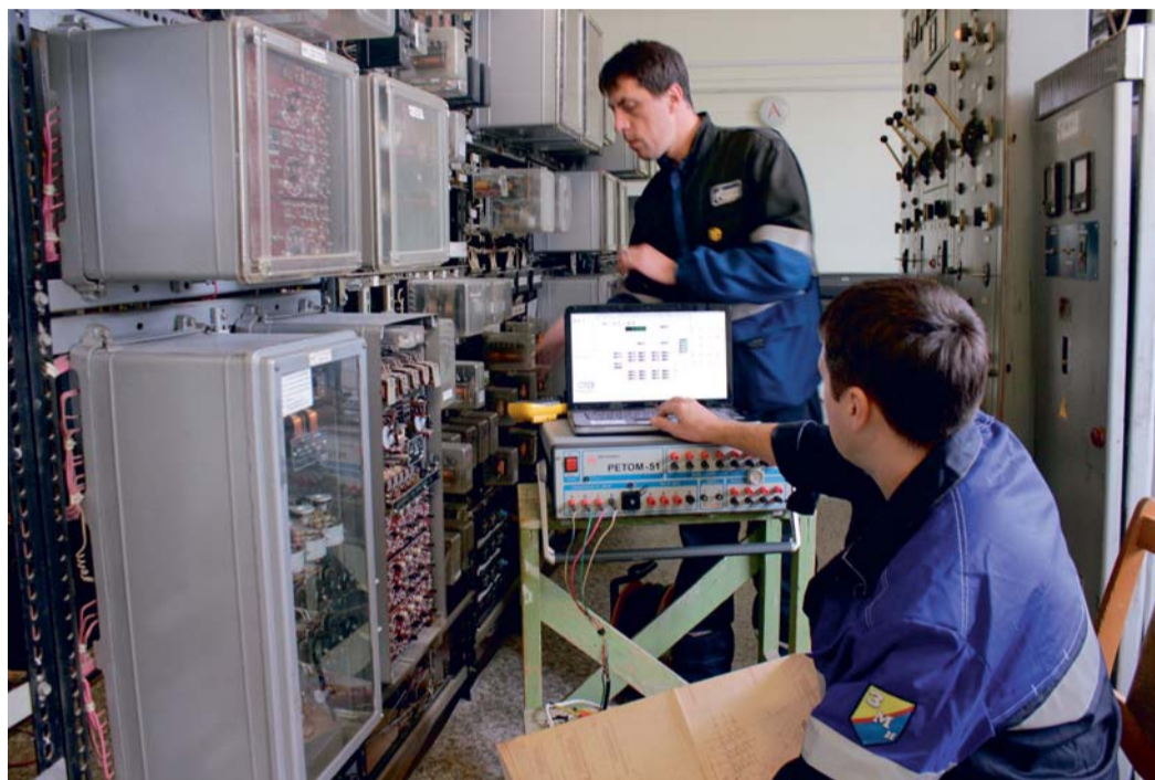
Артём Андришин, электромонтёр РЗА 6-го разряда, и Алексей Осипов, мастер ПЭТЛ, выполняют работы с применением реле томографа-51 по настройке релейной защиты и автоматики ВЛ-110кВ ПС «Базовая»
