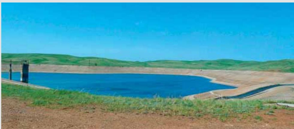
Конечной точкой путешествия стало «Каменное озеро» — ёмкость сезонного регулирования в районе ж/д станции Сырт. Сюда поступает очищенная техническая вода с газоперерабатывающего и гелиевого заводов. В зависимости от сезона изменяется уровень воды. Летом вода из ёмкости используется для полива сельскохозяйственных земель.
